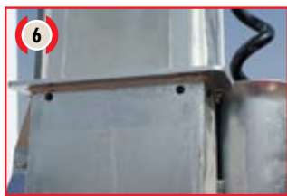
6 Collari di rinforzo ad ogni fine sezione
